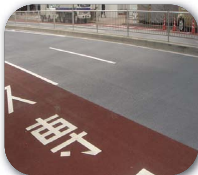
タフクーレ含有遮熱塗料による高耐久性遮熱舗装例
